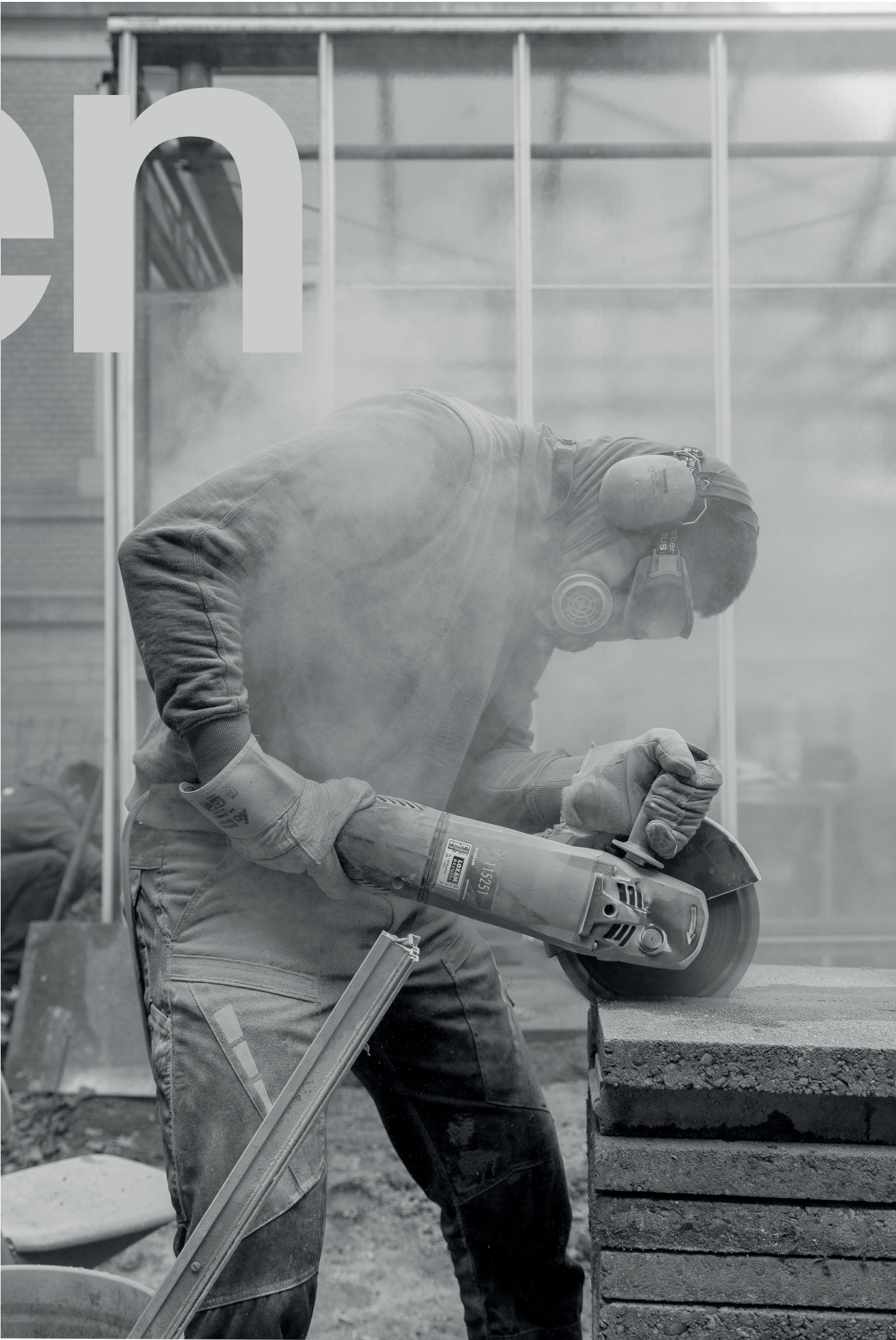
Arbeiten am Glashaus, Bauwoche Wintersemester 2022/2023
